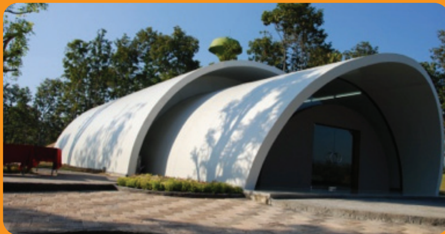
อาคารห้องประชุมทรงกระบอกเสร็จสมบูรณ์ BUILDING COMPLETION
